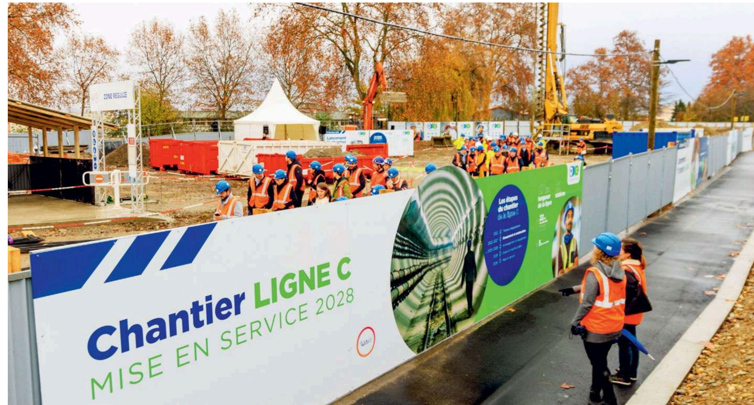
Chantier de la 3ème ligne de Métro (crédit : Toulouse Métropole)
